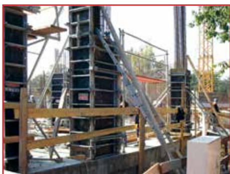
Formowanie słupów - płyty MIDI BOX i zamki szalunkowe
